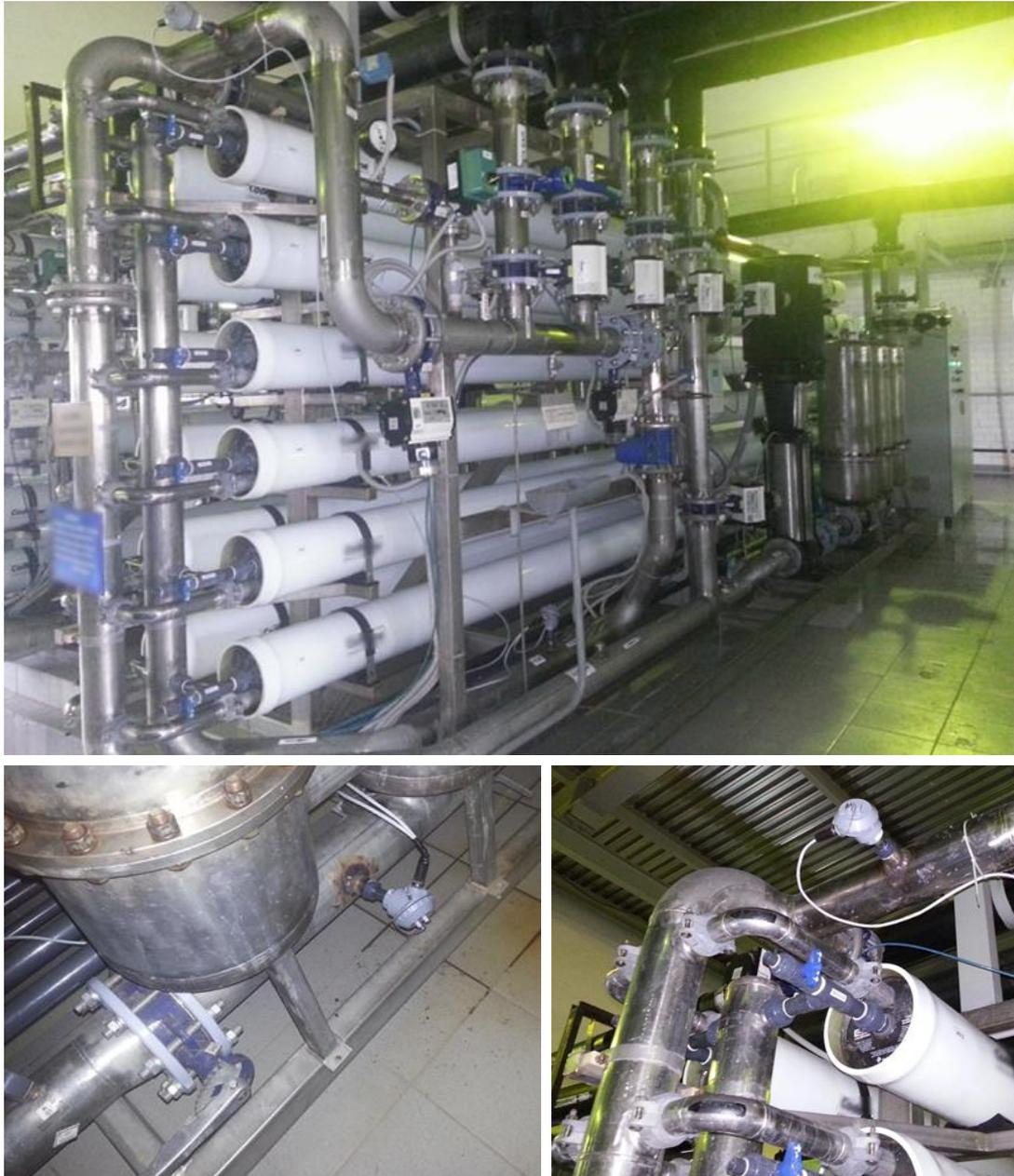
Abbildung 3: Übersicht über das RO-System (oben), ALVIM-Sensor vor dem RO (unten, links), ALVIM-Sensor in der Konzentratleitung (unten, rechts)
